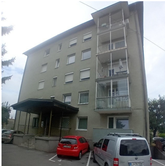
Slika 6.9: Fasada pred prenovo (PP2)
