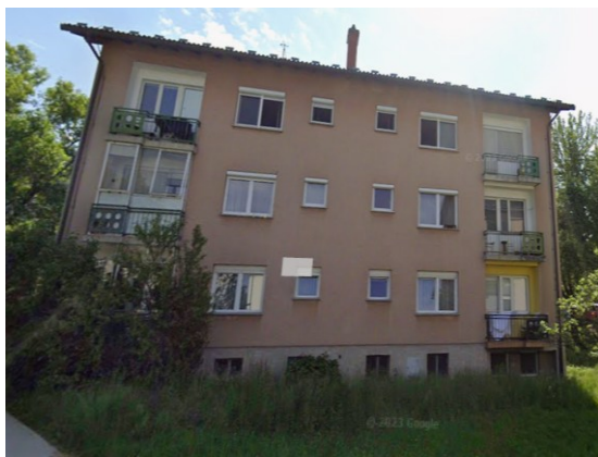
Slika 6.17: Fasada pred prenovo (PP3)
