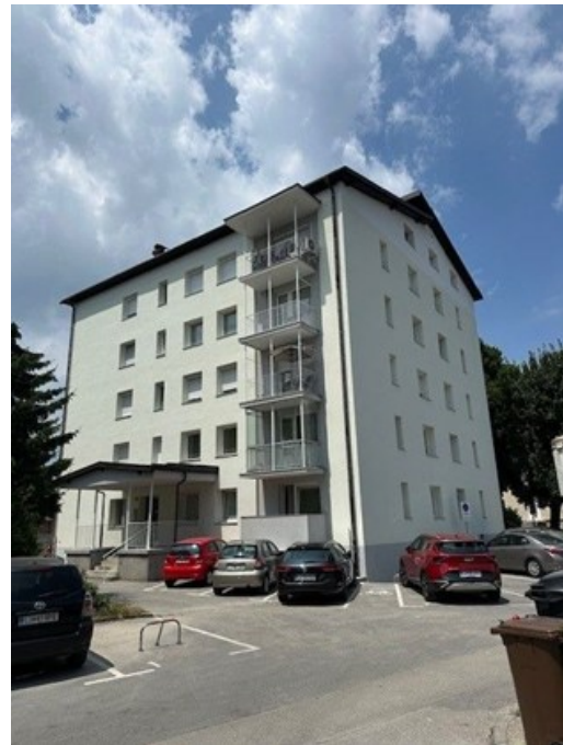
Slika 6.10: Fasada po prenovi (PP2)
