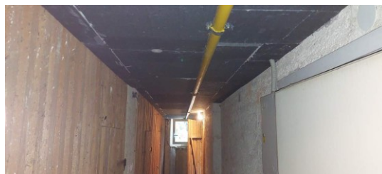
Slika 6.20: Klet po prenovi (PP3)
