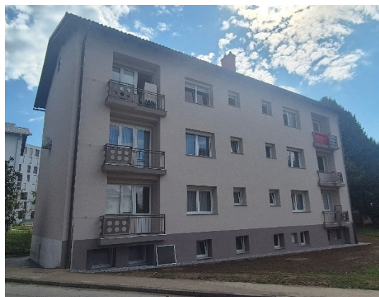
Slika 6.18: Fasada po prenovi (PP3)
