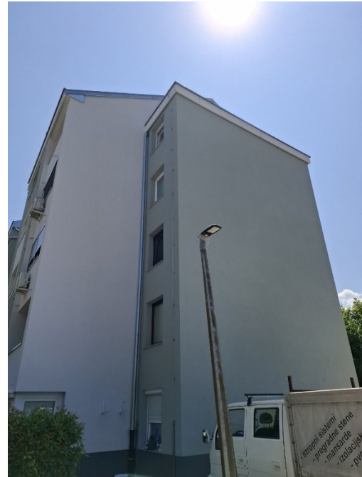
Slika 6.4: Fasada po prenovi (PP1)
