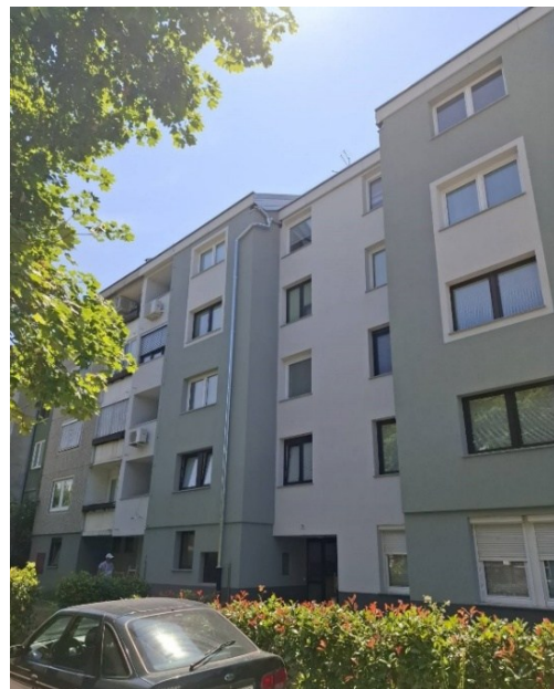
Slika 6.2: Fasada po prenovi (PP1)
