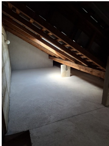
Slika 6.8: Podstrešje po prenovi (PP1)
