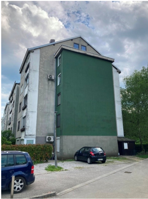
Slika 6.3: Fasada pred prenovo (PP1)
