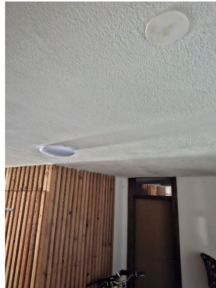
Slika 6.6: Klet po prenovi (PP1)
