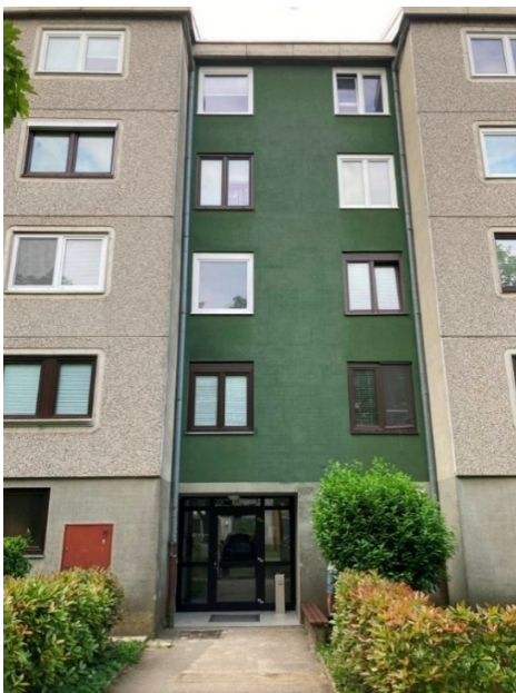
Slika 6.1: Fasada pred prenovo (PP1)
