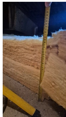
Slika 6.25: Podstrešje po prenovi (PP3)
