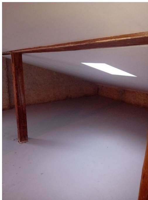
Slika 6.12: Podstrešje po prenovi (PP2)
