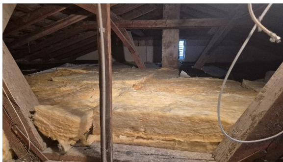
Slika 6.24: Podstrešje po prenovi (PP3)
