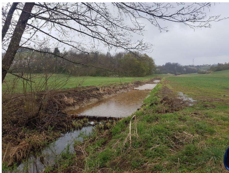
Grajeni ekosistemi za čiščenje kmetijskega odtoka v melioracijskih jarkih (arhiv Limnos).
